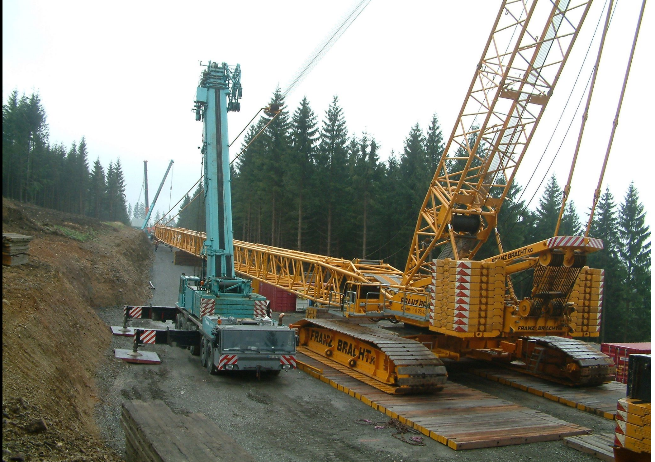
DEMAG-Kranraupe und „Servicekrane“
