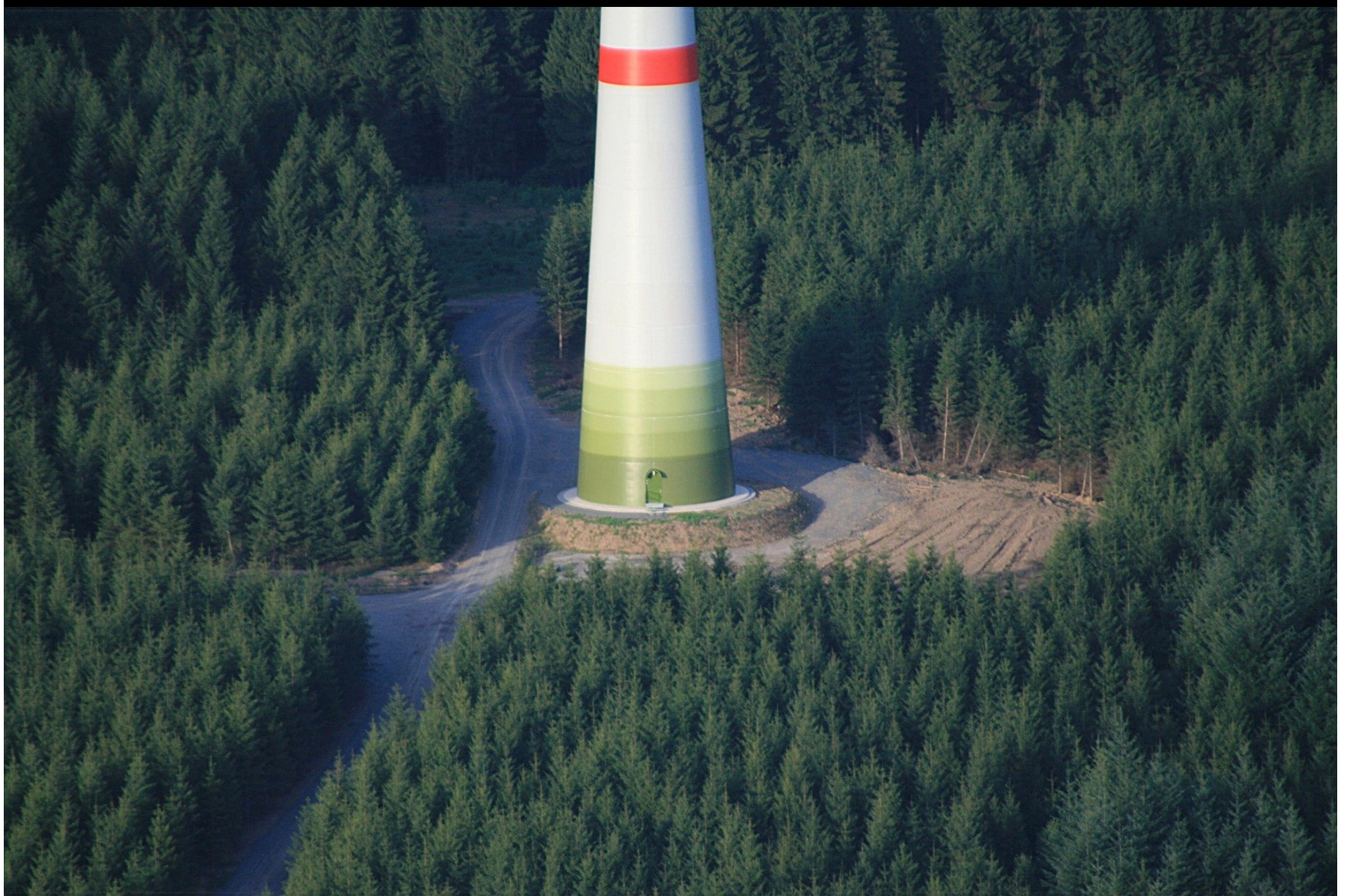
Bürgerwindpark Hilchenbach – für 5 WEA dauerhaft entwaldete Fläche: 1,5 ha
