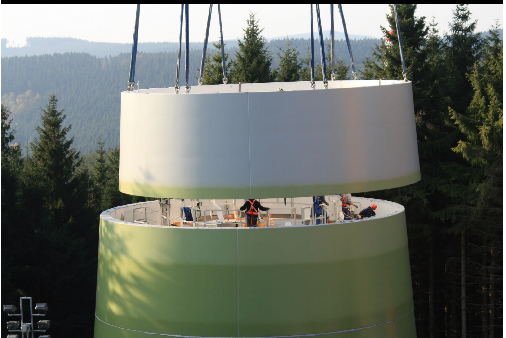
Ein Ringsegment wird gesetzt
