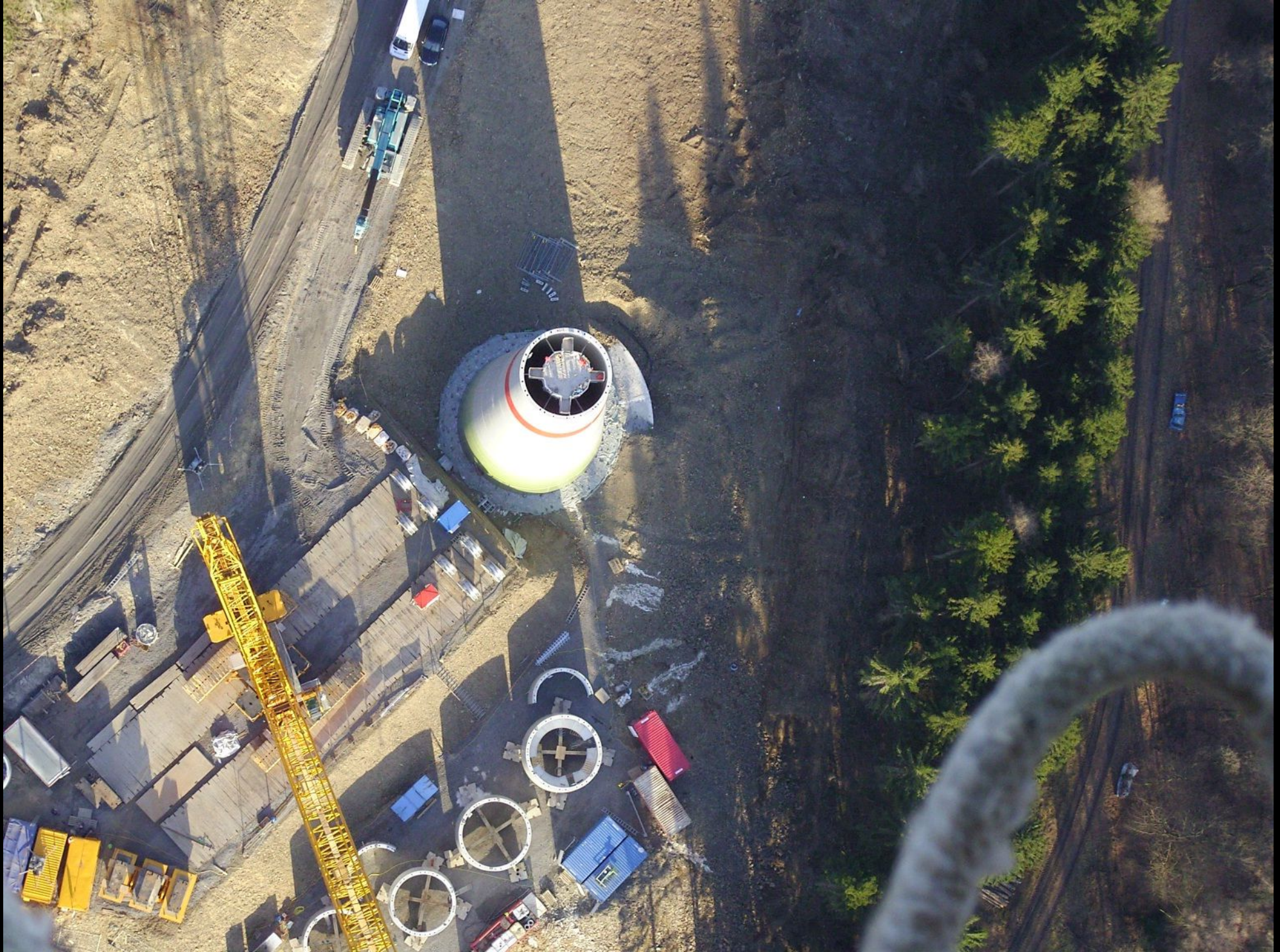
Turm mit Arbeitsbühne von oben
